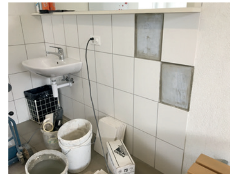
Kaputte Plättli wurden ersetzt...
